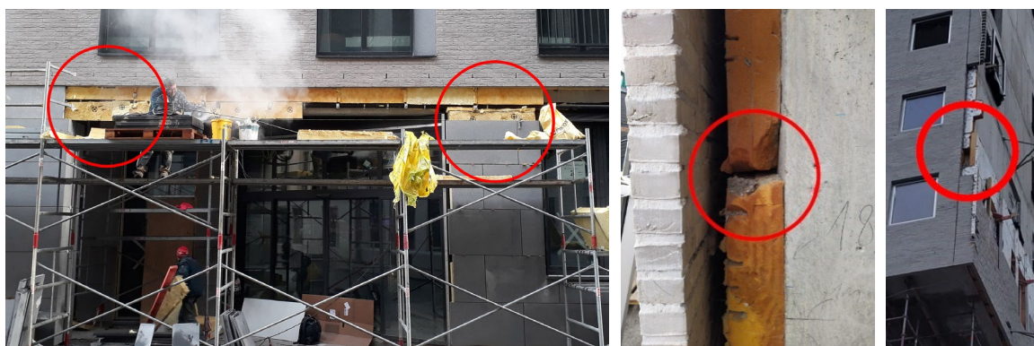
Figuur 11: Gebrekkige uitvoeringskwaliteit in de bouwsector leidt tot een hoge foutenlast (doorheen de EU naar schatting zo'n 10-15% van het bouwvolume voor gekende gebreken) en haalt in het bijzonder de reële energieprestatie naar beneden vergeleken met de ontwerpwaarde. (Foto's auteur: veelvuldig voorkomende gebreken in de isolatie van de gebouwschil)
